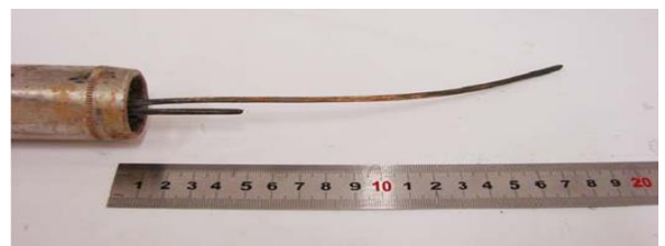
Figura 10 Detalhe da emenda e fios no lado que ocorreu a ruptura
