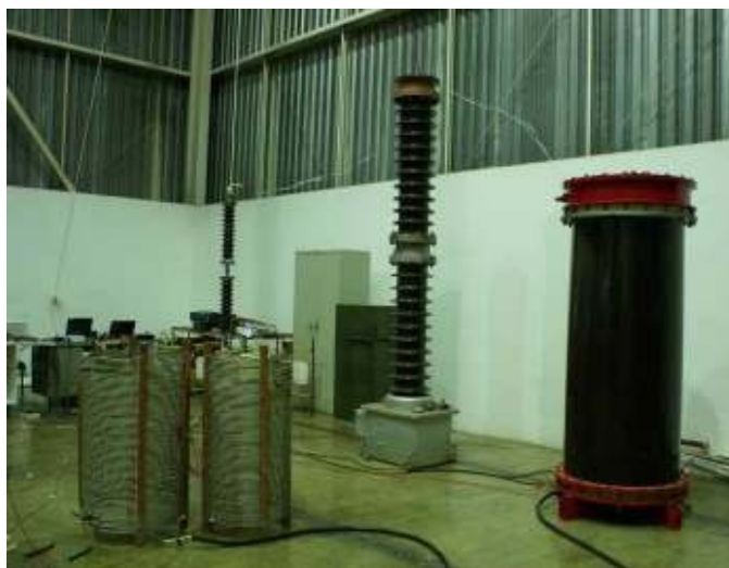
Figura 16 - Implementação do circuito de ensaio – transformador elevador (à esquerda), TPC (centro) e DPC (à direita), e indutores de 1mH para compensação reativa (em primeiro plano).
