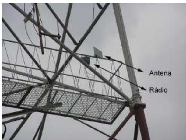
Figura 8: Antena e rádio montados na estrutura de M.O.
